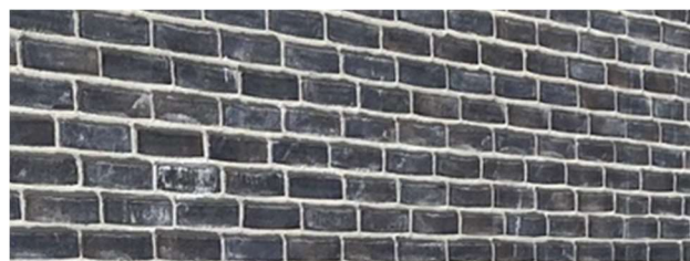
Denne sten eller mørkere opfylder lokalplanens bestemmelser, hvis de fuges med samme mørke farve som stenene.
