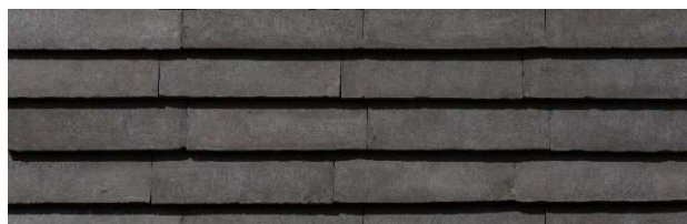
Skærmtegl lagt som klinkbeklædning
